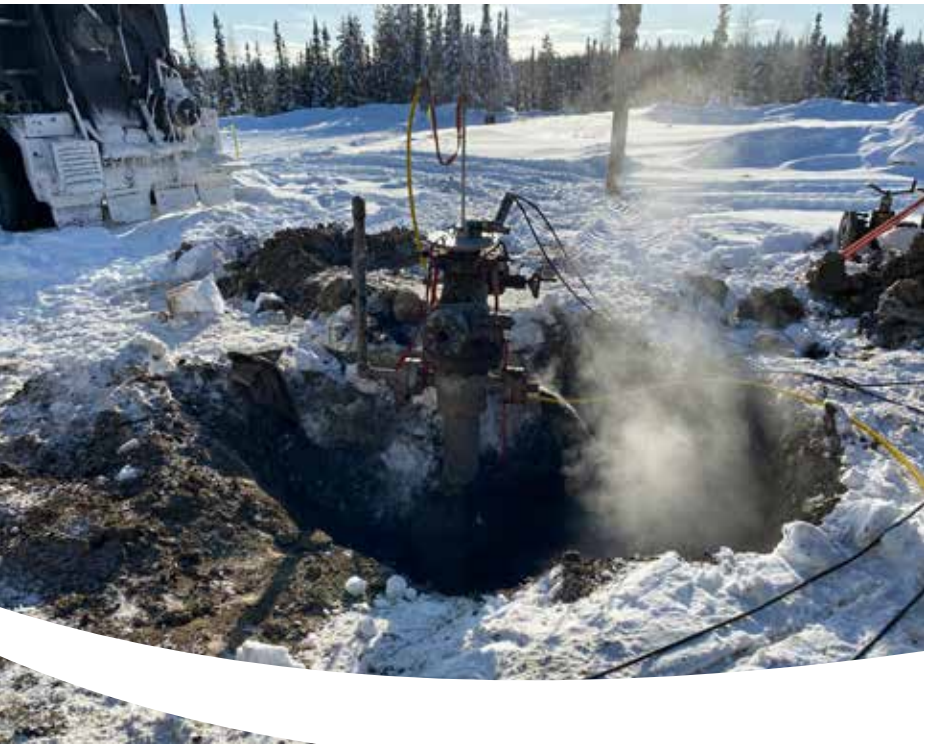
Hydrocoupage d'une tête de puits, collines Cameron, mars 2023. (Photo : OROGO)
