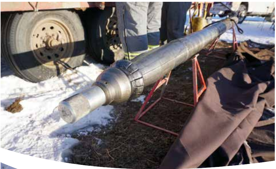
Outil d'expansion de caisson, Liard East Field, février 2023. (Photo : OROGO)
