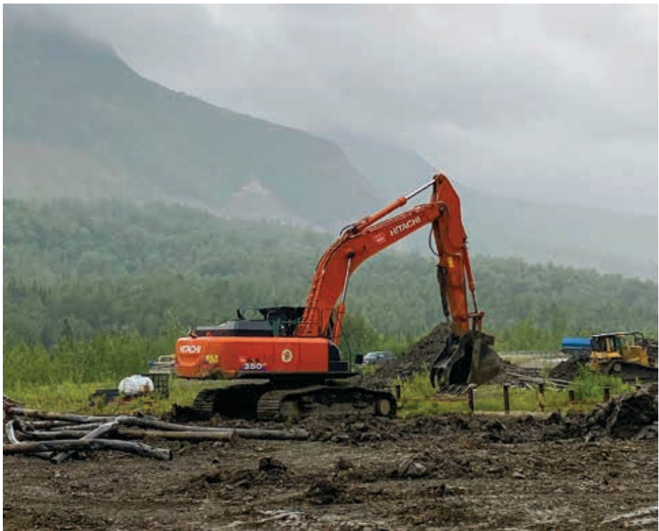
Travaux d'abandon de site près de Fort Liard, en juillet 2025. (BOROPG)
