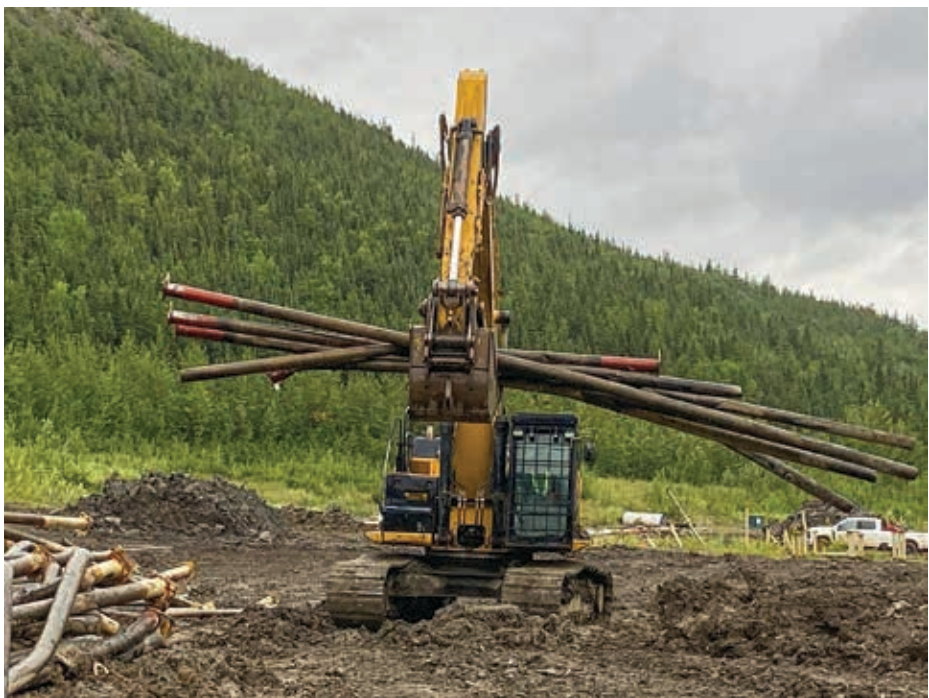
Travaux d'abandon de site près de Fort Liard, en juillet 2025. (BOROPG)
